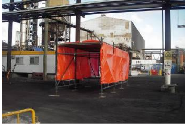
Resim 84: Yayıları düşen nesnelere korumak için kullanılan iskele yapısı
