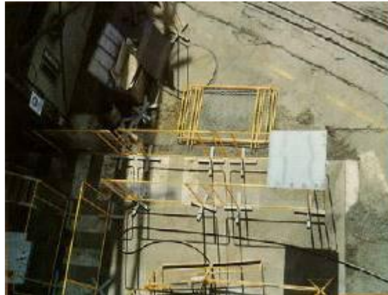
Resim 87: Üstten panel korumalı olarak kurulmuş ağlı bariyerler
