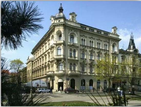
Şekil 8: Zagreb'in merkezindeki Hotel Palace bir su/su ısı pompası kullanıyor
