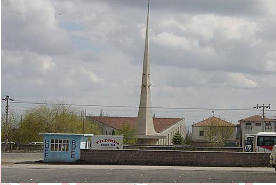
Görsel 12. Derinkuyu Cami görünüşü.
